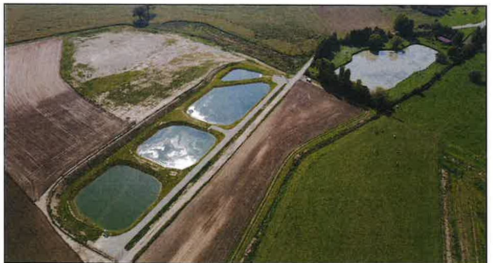
Lagune de Adélange – Septembre 2023
